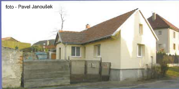
foto po opravě
