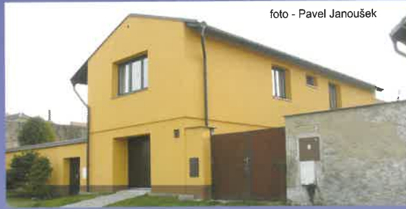
foto po opravě
